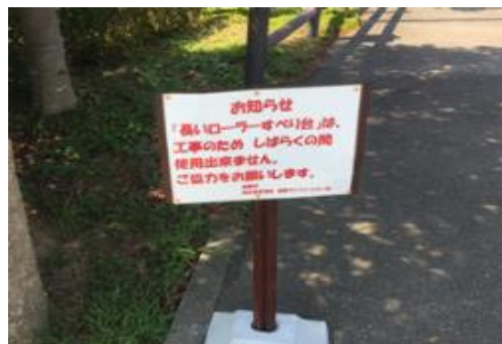
<工事中の案内>
